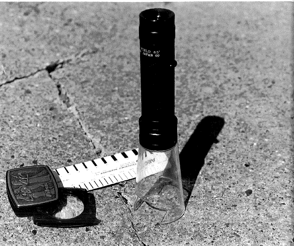
Figur 6. Til måling af vidden af en makrorevne på en betonoverflade er det simplest at anvende en revneviddemålestok. En revneviddemålestok kan med fordel anvendes til revner med vidde på 0,1-5,0 mm og er hurtig og bekvem at betjene. Til måling af makrorevner med vidde på 0,05-0,50 mm på (glatte) betonoverflader og planslib kan en revneviddelup anvendes. En revneviddelup er mere omstændig at anvende end en revneviddemålestok. Revneviddeluppen findes i forskellige versioner og anvendes fortrinsvis i laboratoriet, medens revneviddemålestokken anvendes ved bygværks-inspektion. Foto: AEC.
